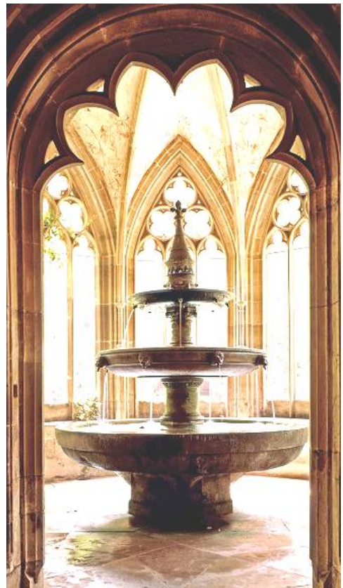
Brunnenhaus, Kloster Maulbronn
